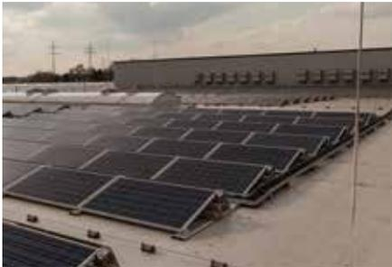
El sistema fotovoltaico de 9800 m<sup>2</sup> que aparece en la foto superior cuenta con 2200 módulos y genera el 20 % de la electricidad utilizada en nuestra recién construida sede alemana en Hannover.
